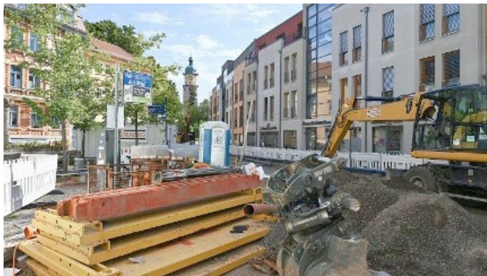
Blick auf die Baustelle in der Schloßstraße aus dem August 2025
