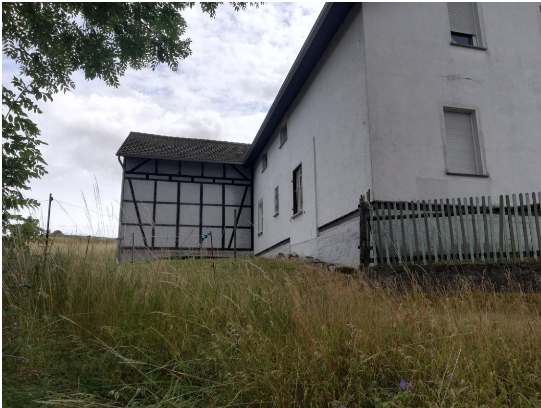
Foto: PNI 21.07.2023 – Zufahrt und Nachbarbebauung
