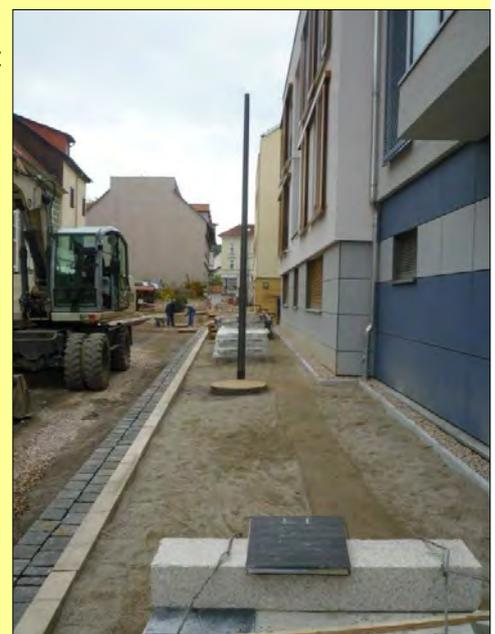
Die Straße Obere Weiße hat eine Ausbaulänge von 90 m. Der Ausbau der Straße erfolgte als verkehrsberuhigter Anliegerweg und Mischverkehrsfläche. Die Fahrbahnbreite variiert zwischen 3,50 m 4,75 m, die Gehwegbreite zwischen 1,00 m und 3,12 m. Gehwege und Fahrverkehrsfläche werden durch Granitborde mit Stich 3 cm voneinander abgegrenzt.
