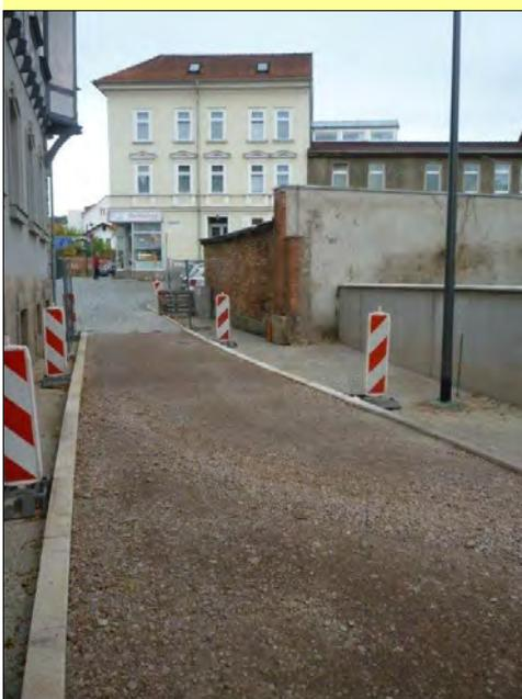
Ausbau war die Straße mit einer bituminösen Oberfläche befestigt. Der Zustand war mangelhaft (Aufbrüche, Unebenheiten, Tragfähigkeitsschäden). Eine
