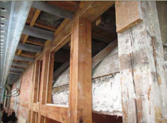
Erneuertes Fachwerk vor dem Verschluss der Gefache und gesichert. Die Fenster im Fachwerkbereich des Obergeschosses wurden ausgebaut, restauriert und mit Isolierverglasung energetisch ertüchtigt.
