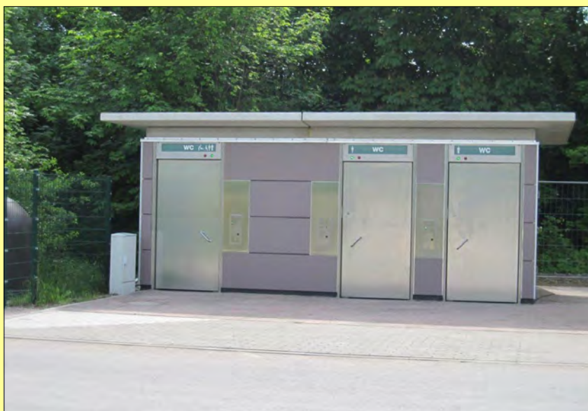
2010 neu errichtete Toilettenanlage am Wollmarkt
