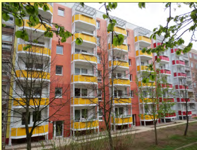
Am Fürstenberg 44-48 nach der Modernisierung
