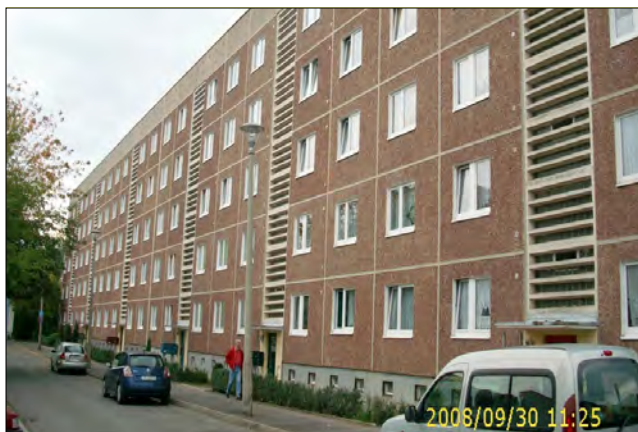
Nordfassade Triniusstraße 28-28e im September 2008
