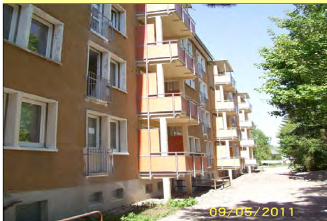
unsanierte Gebäude Am Dornheimer Berg
