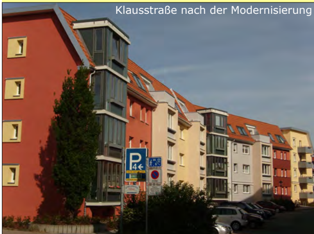
Klausstraße nach der Modernisierung
