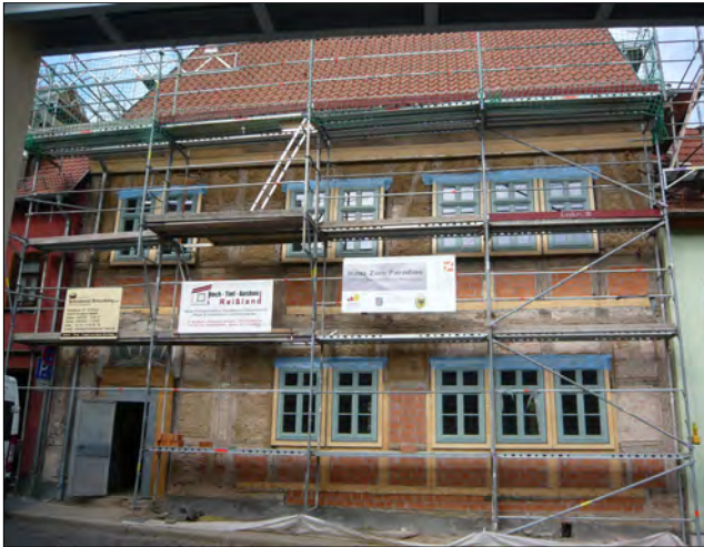
Kohlgasse 11 während der Sanierung
