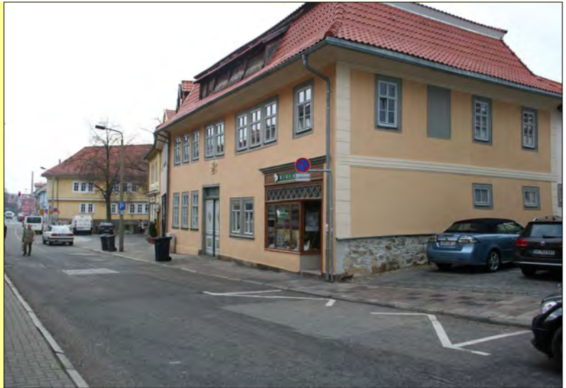
Längwitzer Straße 3 in heutigem Zustand
