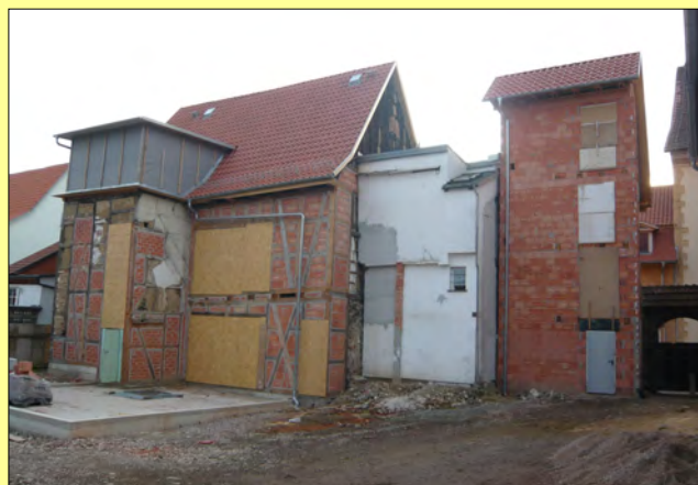
Hofansicht nach Durchführung der Sicherungsmaßnahmen
