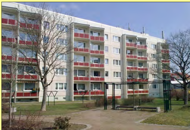
Südfassade Goethestraße 5-5c
