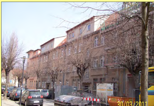
Willibrordstraße 1-7 zu Beginn der Sanierungsmaßnahme
