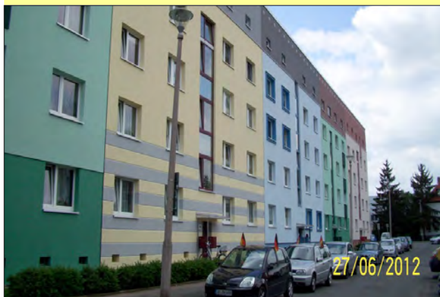
Wärmegeämmte Nordfassade Triniusstraße 28-28e
