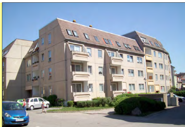
Gebäude Klausstr./Karl-Marien-Str. vor der Sanierung
