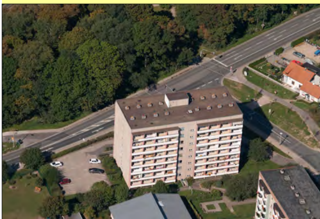
Ilmenauer Straße 8 im Ostviertel
