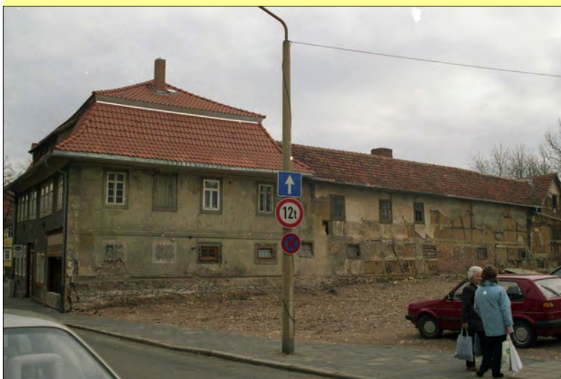
Längwitzer Straße 3 vor der Sanierung
