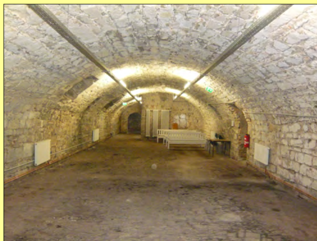
Münzkeller nach der Nutzungssicherung
