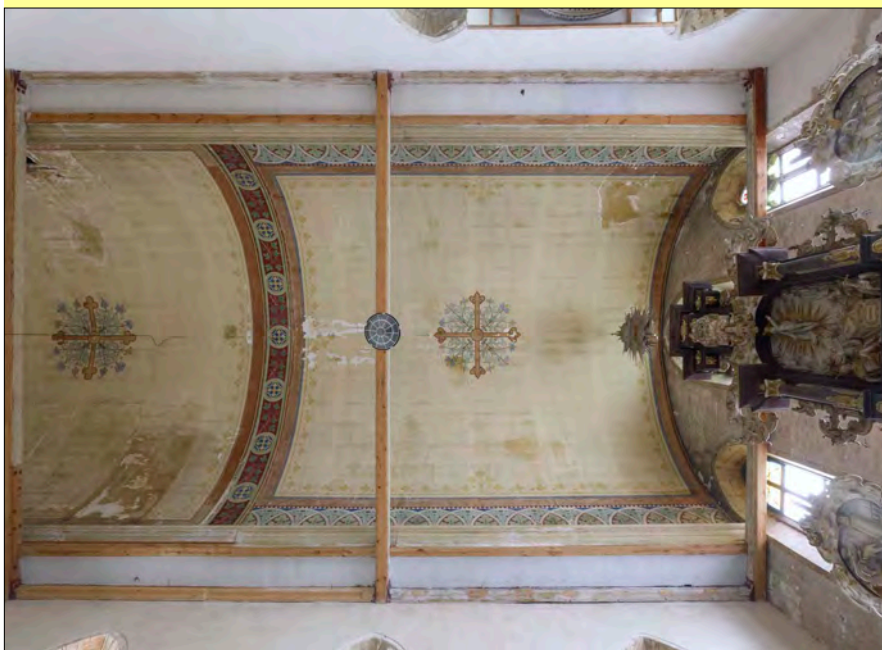
Tonnendecke der Oberkirche vor der Restaurierung
