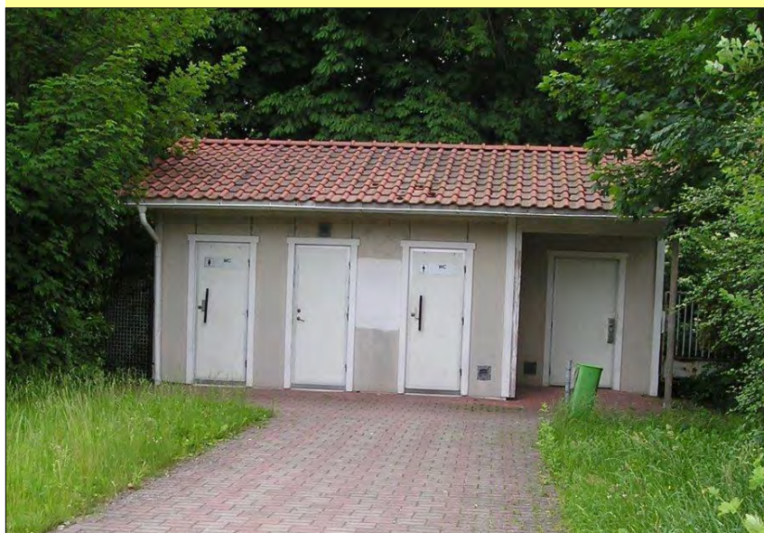
Alte Toilettenanlage am Wollmarkt vor dem Abbruch
