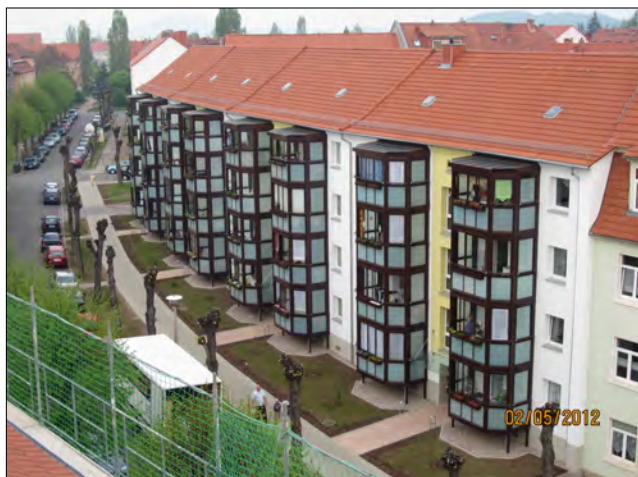
Bielfeldstraße 13-19 nach der Modernisierung
