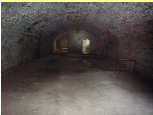
Münzkeller vor der Nutzungssicherung
