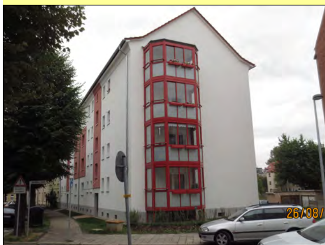
Bielfeldstraße 6-8 nach der Modernisierung
