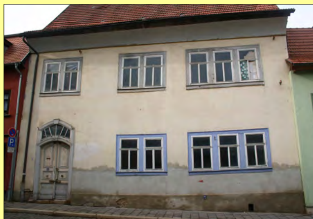
Kohlgasse 11 vor der Sanierung, Straßenansicht
