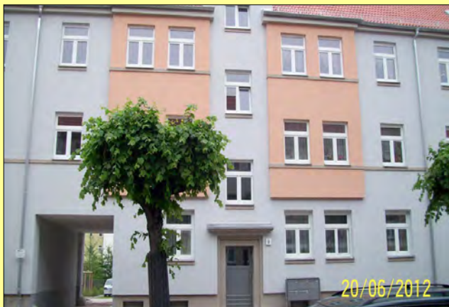
..... und kurz vor Abschluss der Arbeiten
