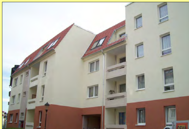
..... und nach Abschluss der Sanierungsmaßnahme
