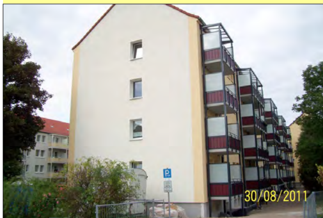
Gebäude Am Dornheimer Berg nach der Sanierung
