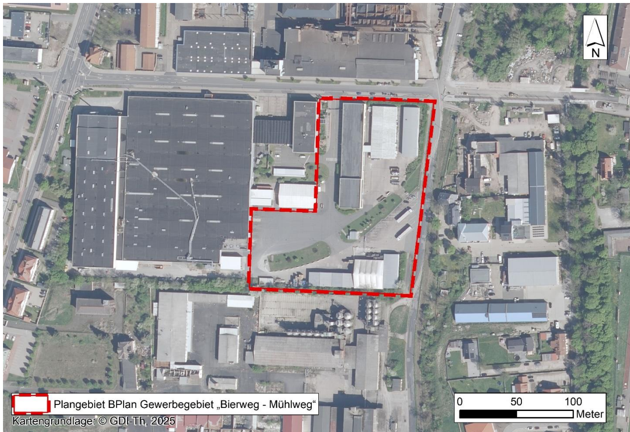
Abbildung 2: Luftbildaufnahme des Plangebietes
