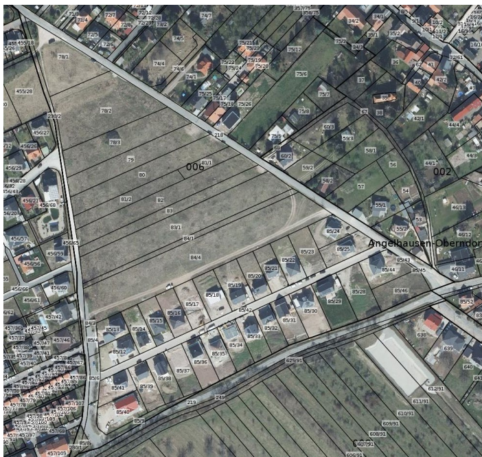
Abbildung 3 Übersicht zur Bebauung im Bereich „Wohnanlage südlicher Bereich“ | Quelle: ThüringenViewer
